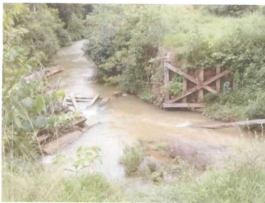
Foto 03. Ponte sobre o Rio Lagoinha.
