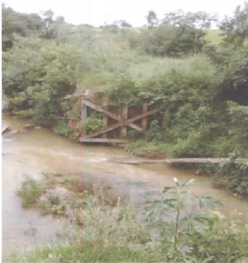
Foto 01. Ponte sobre o Rio Lagoinha.
