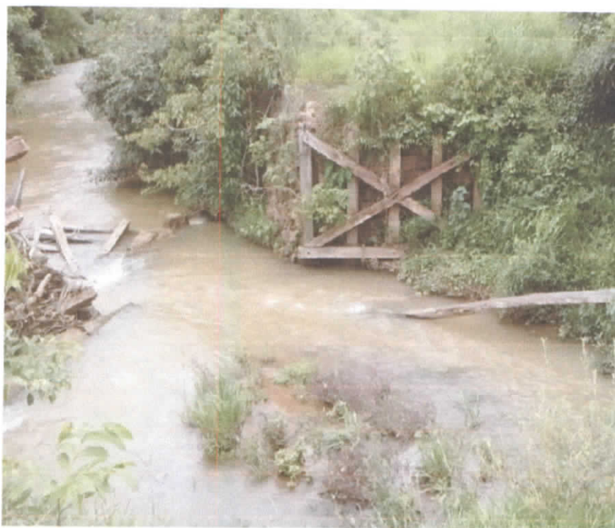
Foto 02. Ponte sobre o Rio Lagoinha.
